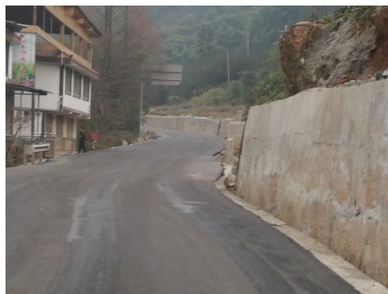
水泥砼防护边坡
