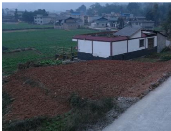
龙门乡龙兴村施工驻地
