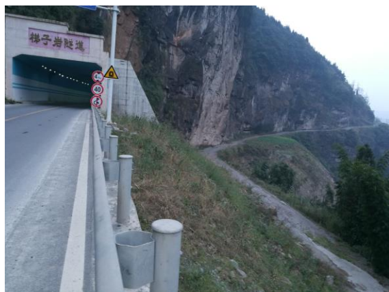
植被防护边坡
